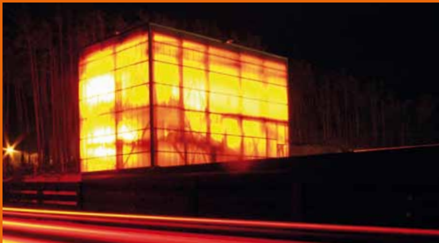
[oben] Firmensitz in Klausen [unten] Kieswerk in Vahrn
